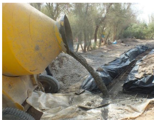
شکل ۳- پر شدن ترانشه با ملات سیمان
