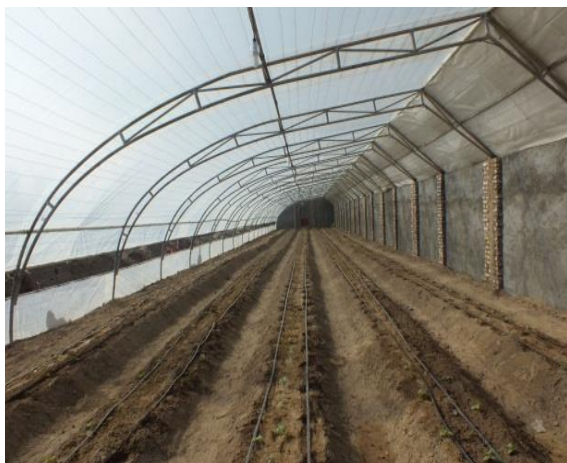
شکل ۸- آستر سیمان سیاه دیوار داخلی
