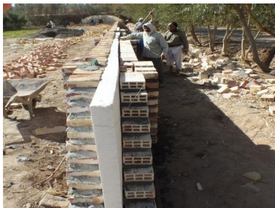
شکل ۶- به ترتیب از راست موقعیت دیوار بیرونی، عایق پلاستوفوم و دیوار داخلی (آجر گری)
