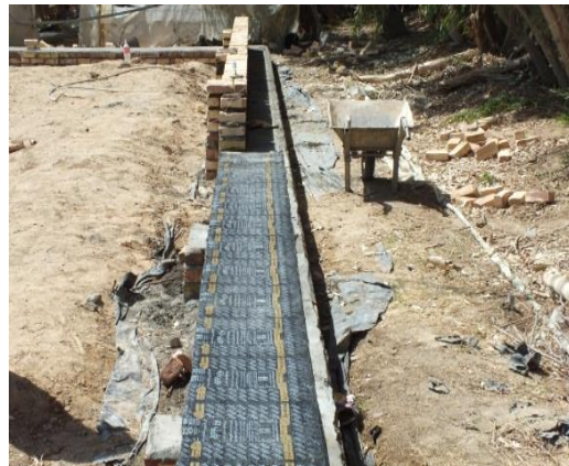
شکل ۵- کرسی چینی و عایق بندی
