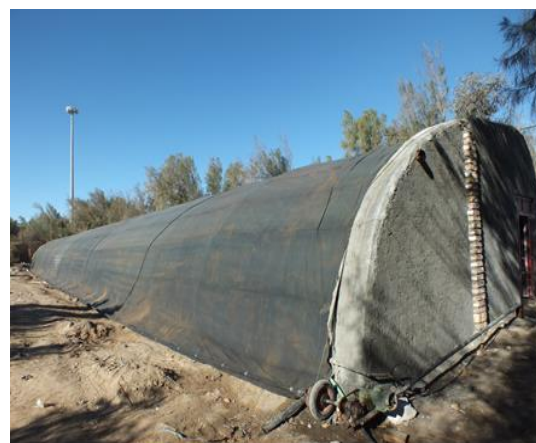
شکل ۱۳- قرار گرفتن عایق شب روی پوشش پلاستیک
