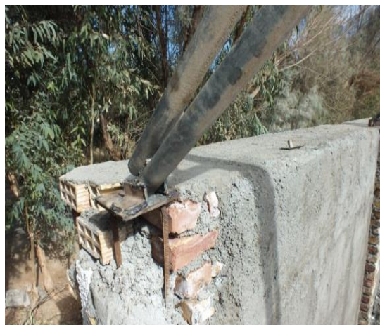
شکل ۷- نصب صفحه روی دیوار جهت اتصال سازه
