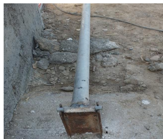
شکل ۱۵- موقعیت قرار گرفتن پایه ستون تلسکوپی
