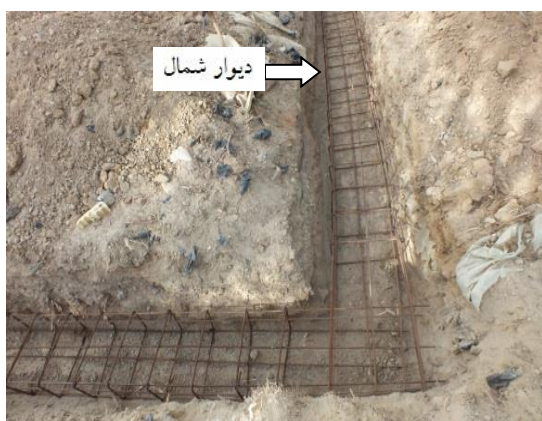
شکل ۲- قرار گرفتن آرماتور در فونداسیون
