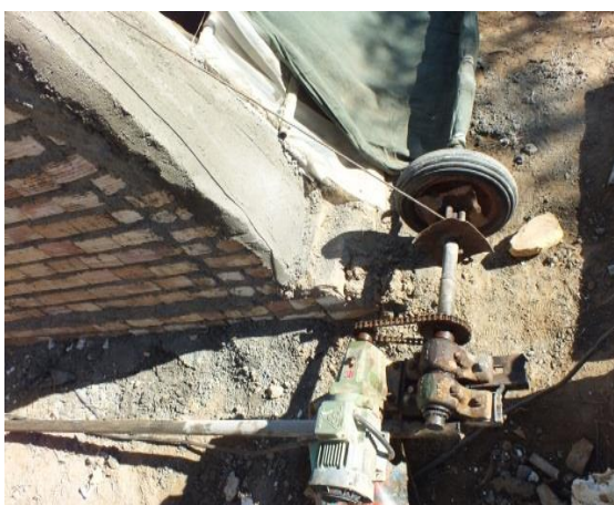
شکل ۱۶- نصب موتور در قسمت انتهای ستون تلسکوپی
