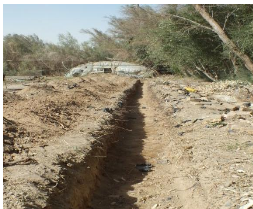
شکل ۱- حفر ترانشه دیوار شمالی
