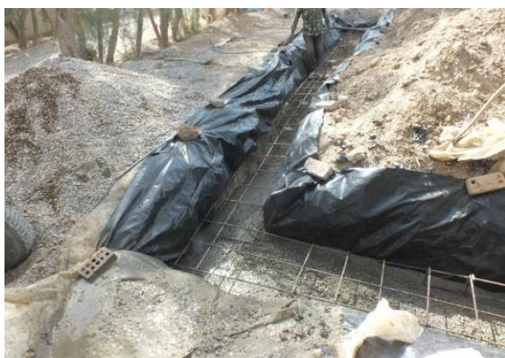
شکل ۴- استفاده از پلاستیک جهت جلوگیری از ریزش
