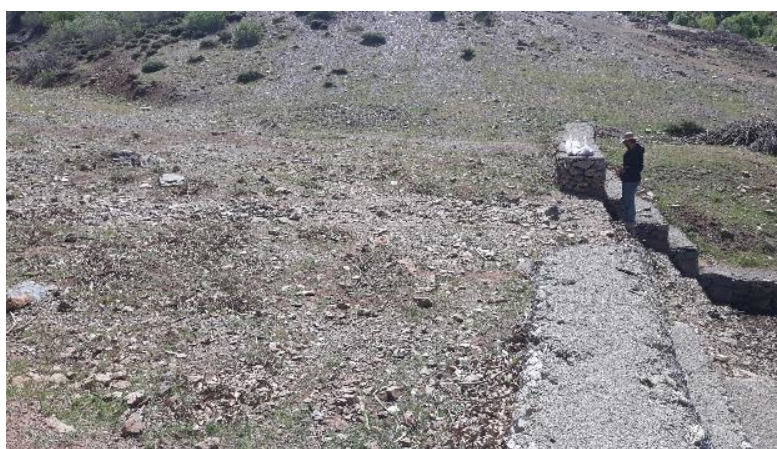
شکل ۳- تصویر یکی از بندهای اصلاحی پرشده با رسوبات.
